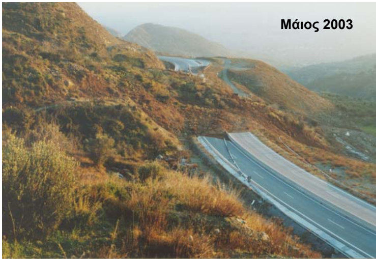
Σχήμα 1. Γενική άποψη από βορά προς νότο της κατολίσθησης στην Τσακώνα μετά την ολοκλήρωση του φαινομένου το Μάιο του 2003.
